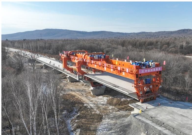
11月5日,中铁四局哈(尔滨)伊(春)高速铁路铁力至伊春段2标项目部(二公司)箱梁架设完成。哈伊高铁正线全长299公里,设计时速250公里。其中,项目部管段全长52.022公里,施工内容包括路基37.24公里、桥梁29座、连续梁5联,箱梁预制架设465孔。项目建成后,将有效拓展东北地区的高铁辐射范围,加强北部边疆地区与内陆发达地区的经济联系,打造区域经济增长的新引擎。
