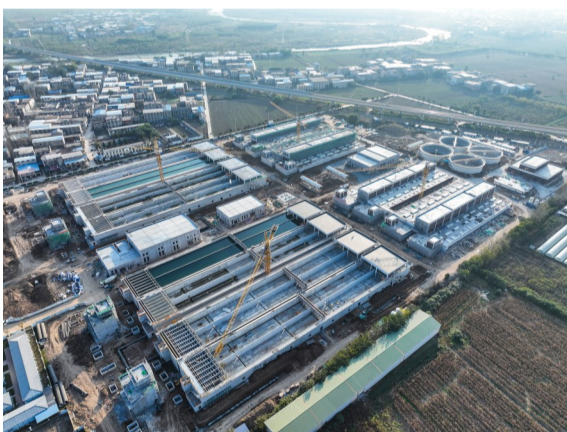
阜阳市第四水厂沉清叠合池满水试验 詹燕 摄(影像四局)
