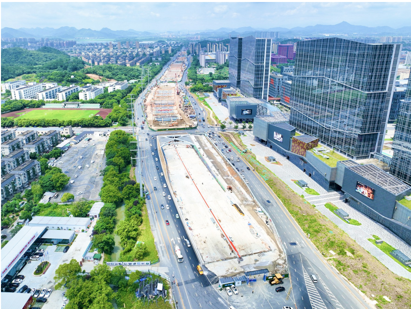
杭州市文一西路西延一期工程智溢路至数云路段主体隧道结构完成 张世鹏 摄(影像四局)
