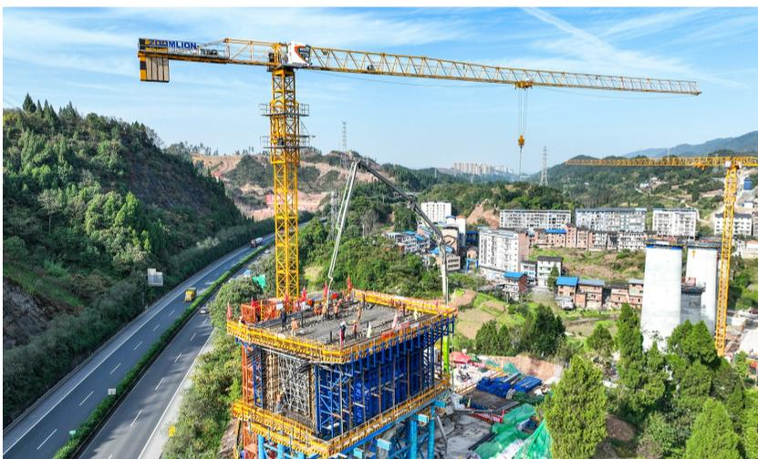
11月17日,中铁四局西(安)渝(重庆)高速铁路安康至重庆段7标项目部(二公司)樨郎特大桥跨包茂高速公路连续梁0号块浇筑完成。这是西渝高铁康渝段首个浇筑完成的连续梁0号块,标志着西渝高铁康渝段进入桥梁上部结构施工阶段。
