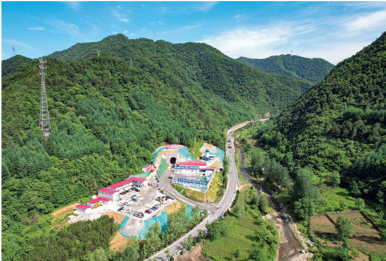
徐家坪隧道出口
