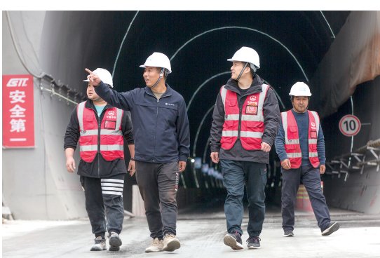
徐家坪隧道施工坚持工序报验自检
