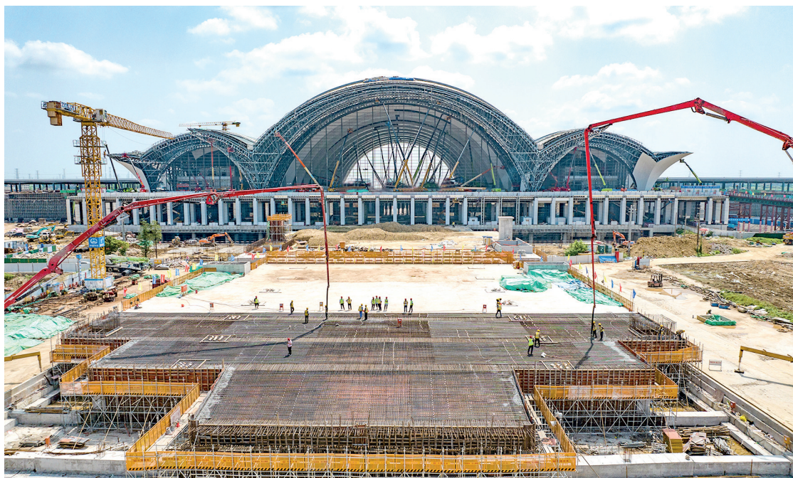
最后一段顶板混凝土浇筑 风元豪 摄(影像四局)
