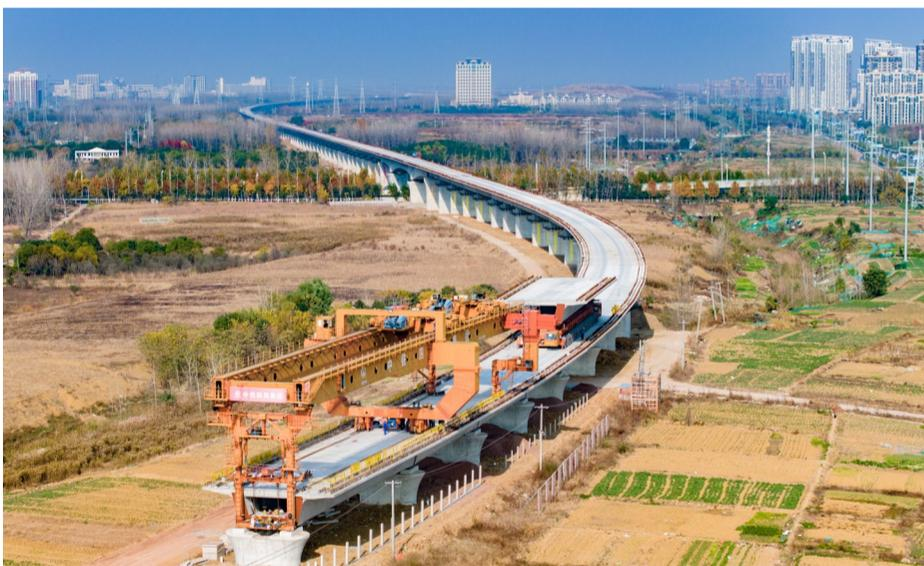
合新铁路箱梁架设施工
