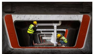
工人正在安装箱梁内部排水管
