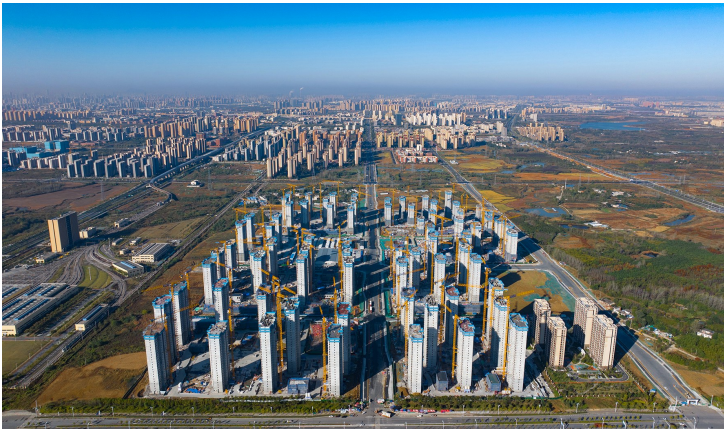
磨店家园三期安置房项目预制构件安装 刘志旭 摄(影像四局)
