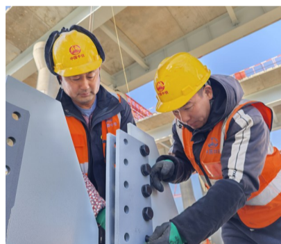
工人对纵梁检修道护栏进行挂接
