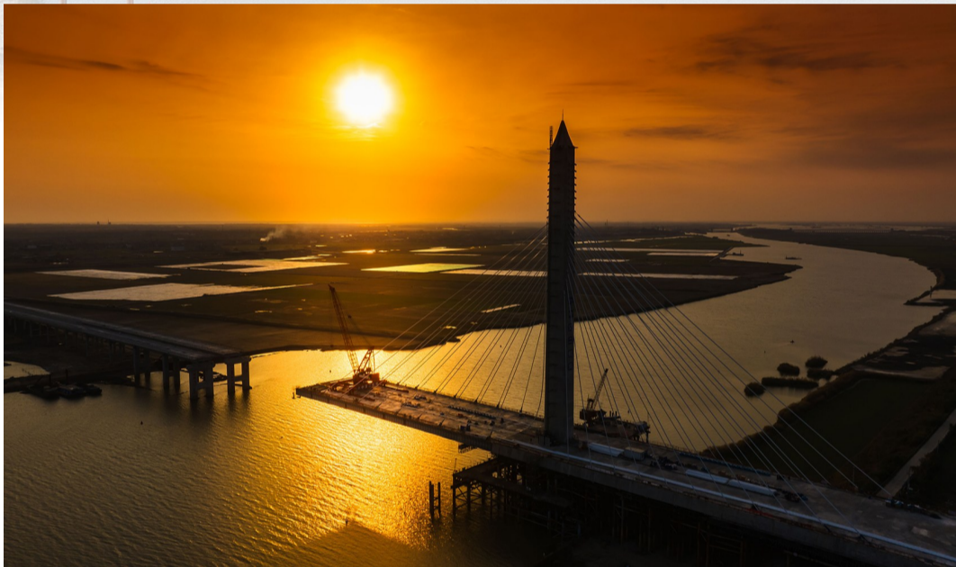
夕阳下的大桥建设工地
