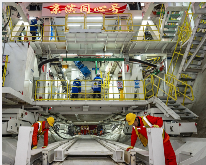
1号台车底部管片小车运输
