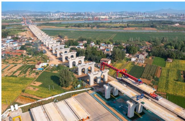
近日，中铁四局八分公司研发的“JQBS1100型单臂架桥机”获得国家知识产权局外观设计专利授权。该型单臂架桥机是目前国内高速铁路箱梁架设最大吨位的单臂架桥机，适应能力强，相比传统架桥机架梁综合工效可提高1倍。
