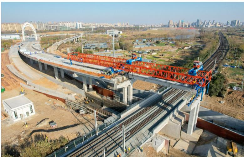
12月7日，中铁四局四公司承建的滁州市将军山路桥工程上跨京沪铁路首片箱梁架设。该工程全长1.14公里，其中上跨京沪铁路需要架设6片箱梁，分五次封锁施工架设完成。此次架设的首片箱梁长29.2米、重105.3吨。
