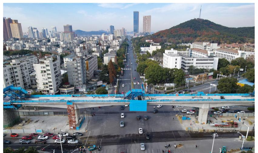
12月14日,中铁四局一公司承建的宁(南京)马(鞍山)城际铁路(马鞍山段)跨湖南路五岔路口连续梁合龙。宁马城际全长65.2公里,设20座车站,设计时速为120公里。此次合龙的连续梁长148.096米,悬浇段采用挂篮支撑体系进行施工。项目建成后,南京、马鞍山两市中心城区仅需30分钟即可互通互联,将为安徽省增加一条融入长三角的“黄金道”,促进安徽、江苏两省经济高质量发展。
