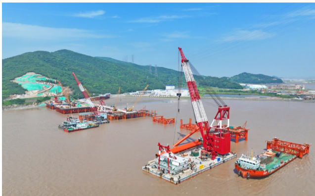
鸟瞰中铁四局西堠门公铁两用大桥施工现场
