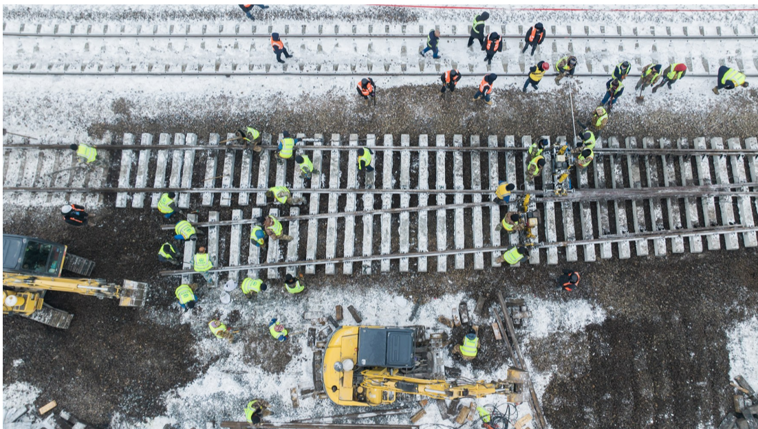
道岔插铺到位
