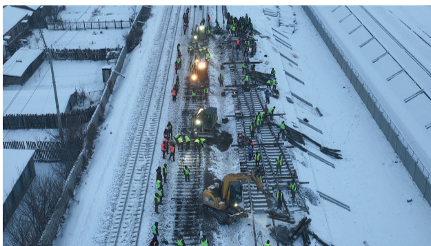
插铺施工现场
