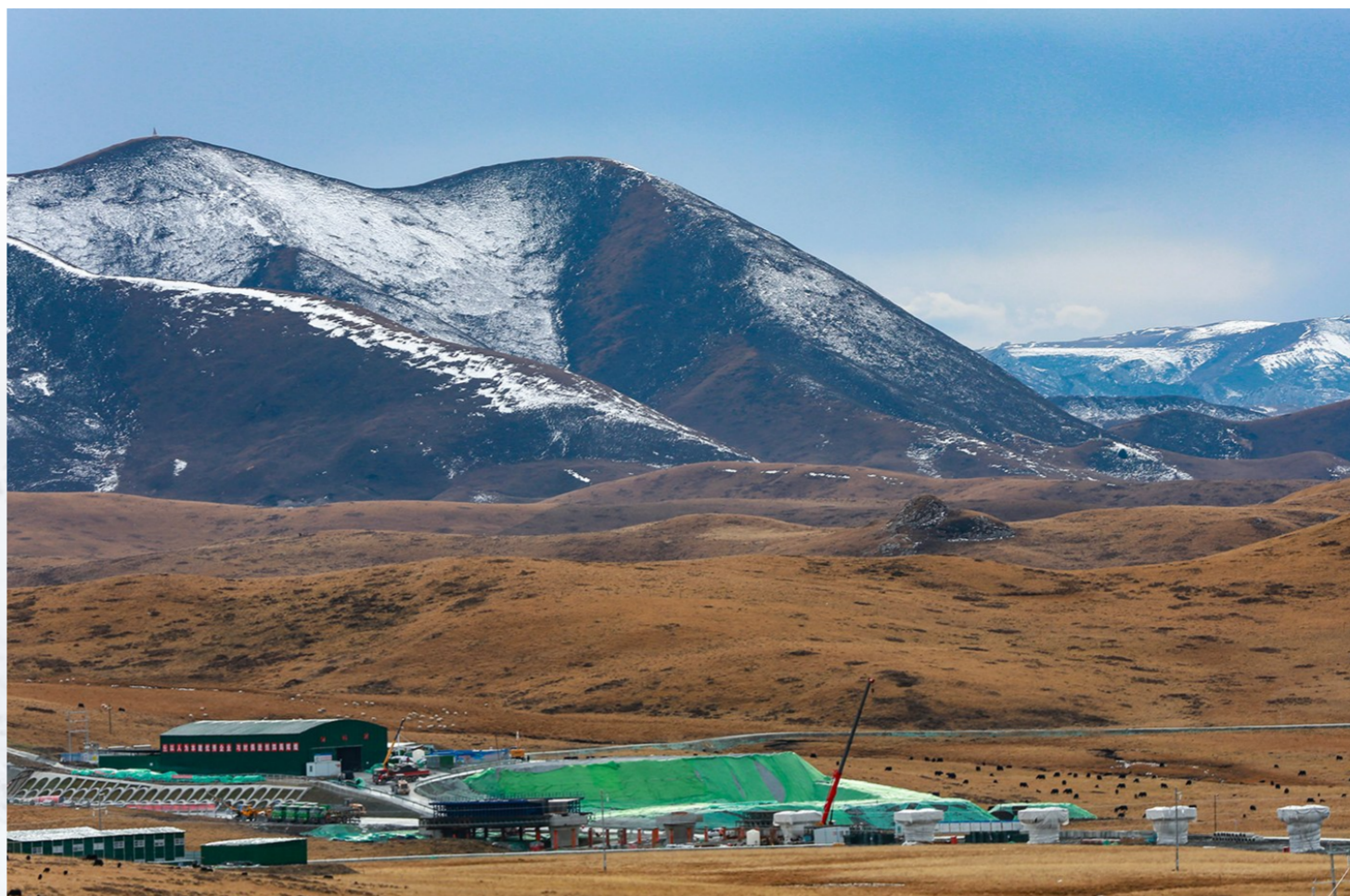
西成铁路1标二分部环保施工规范到位
