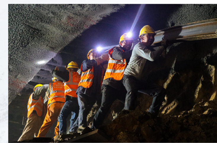
工人正在进行钢拱架安装
