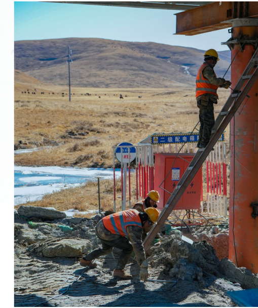
工人桥下施工,背后是开冰河水与漫山牛群
