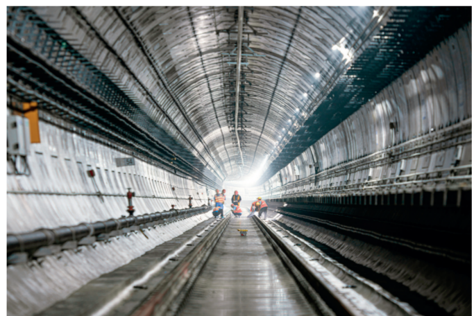
济南市轨道交通R3线一期工程 参建单位:中铁四局七分公司、八分公司、四公司
