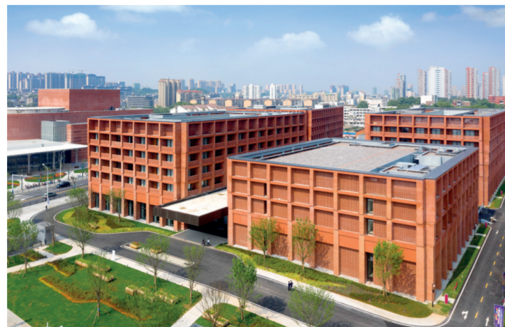
景德镇陶溪川凯悦酒店项目 参建单位:中铁四局市政公司
