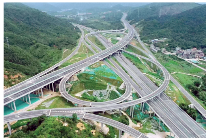
汕(头)湛(江)高速公路惠州至清远段 参建单位:中铁四局五公司
