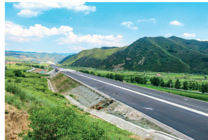
延庆至崇礼高速公路河北段 参建单位:中铁四局四公司
