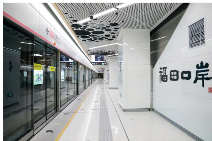
深圳市城市轨道交通10号线工程 参建单位:中铁四局五公司、安装公司
