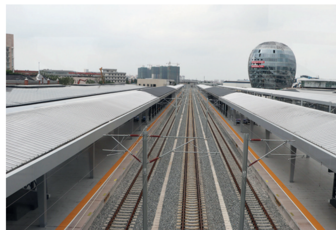
沪昆线嘉兴站站房改扩建工程 参建单位:中铁四局二公司
