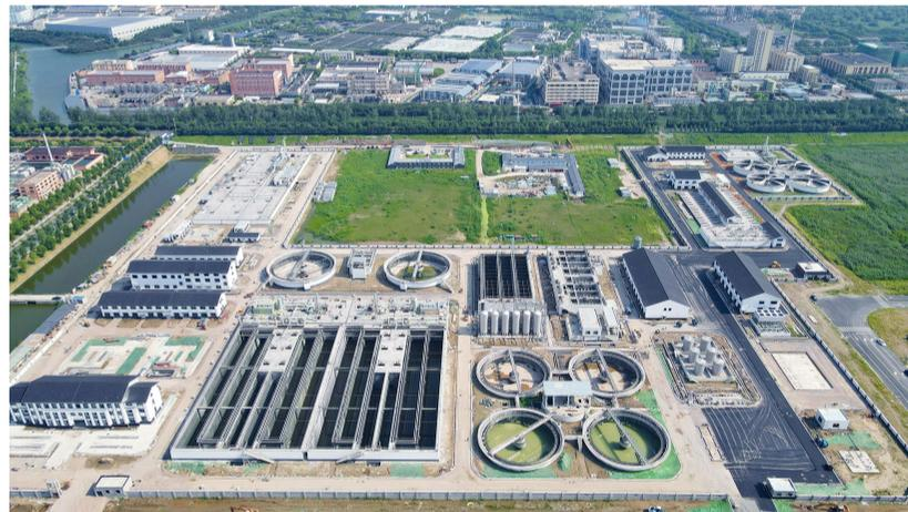
2023年12月25日,中铁四局市政公司承建的绍兴市上虞区工业污水处理异地扩建一期工程竣工验收。该工程是浙江省“六个千亿”产业投资工程、绍兴市化工行业“一园式”发展策略实施的重要基础设施,同时也是上虞区政府“五个一批”重大项目之一。该工程位于杭州湾上虞经济技术开发区产业拓展区,用地面积156.5亩,整体规划为新建处理能力15万吨/日的污水处理厂一座,一期先行建设5万吨/日工业污水处理线一条,包括37个主要构筑物 and 建筑物。
