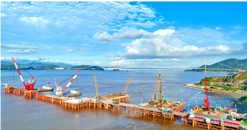
建设中的甬舟铁路西堠门公铁两用大桥 牛森森 摄
