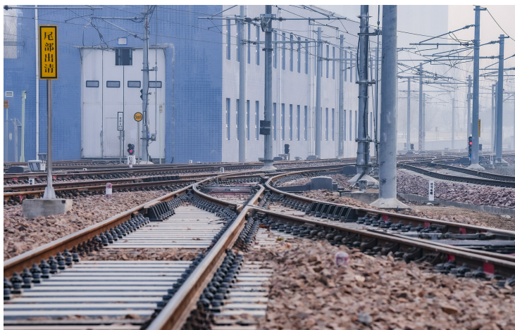
更新改造后的郑州地铁1号线凯旋路停车场出入线焕然一新。
