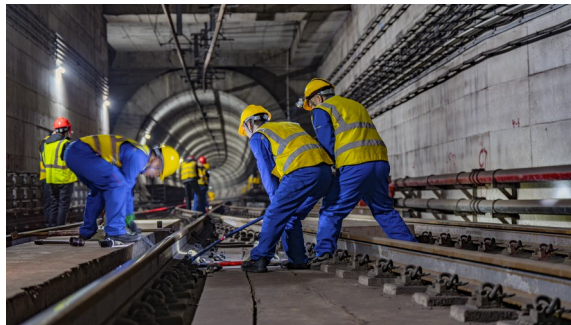
凌晨2点,项目部维保作业班组开始进行线路几何尺寸调整整修和设备零部件更换。
