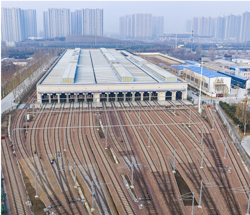
郑州地铁1号线凯旋路停车场失效轨枕更换工作完成,项目部维保作业班组正在对停车场出入场线进行最后的安全检查,确保车辆运营安全。
