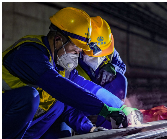
凌晨1点,项目部维保作业班组进入郑州地铁1号线紫荆山站区间隧道,进行钢轨标识标记喷涂。
