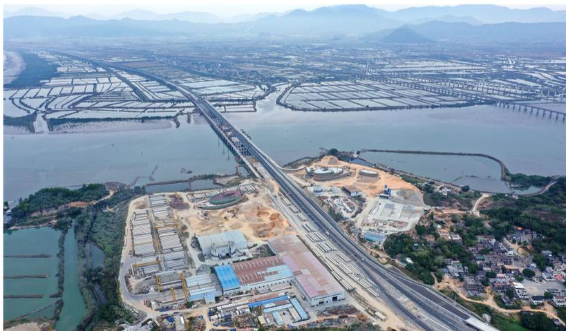
← 1月4日,中铁四局深汕西高速改扩建项目最后一块预制梁浇筑完成,为后续架梁施工提供有利条件。深汕西高速全长146.1公里,采用双向8车道高速公路标准改扩建。中铁四局承建深汕西改扩建项目全长11.09公里,承担全线3个标段共2796根预制梁生产任务。
