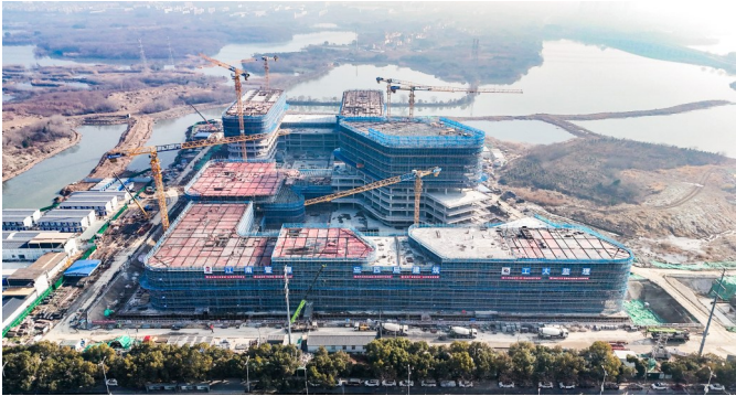
主体结构进入冲刺阶段 赵俊鹏 摄
