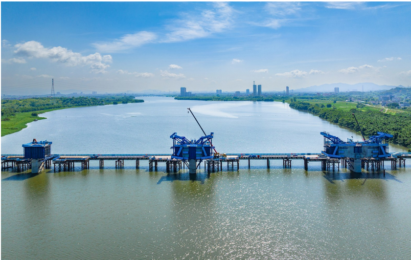
揭惠铁路榕江南河特大桥施工 李小艳 摄
