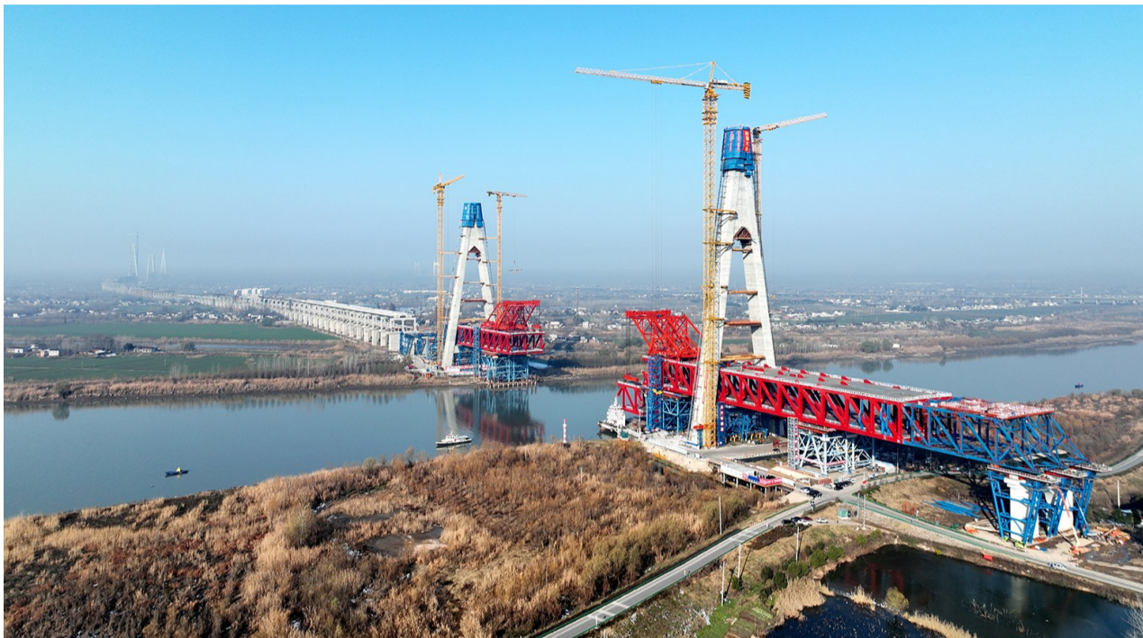
巢马城际铁路马鞍山公铁两用长江大桥副汉航道桥项目施工现场全景
