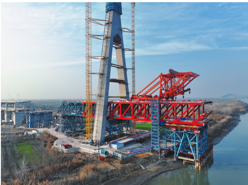
钢梁架设作业
