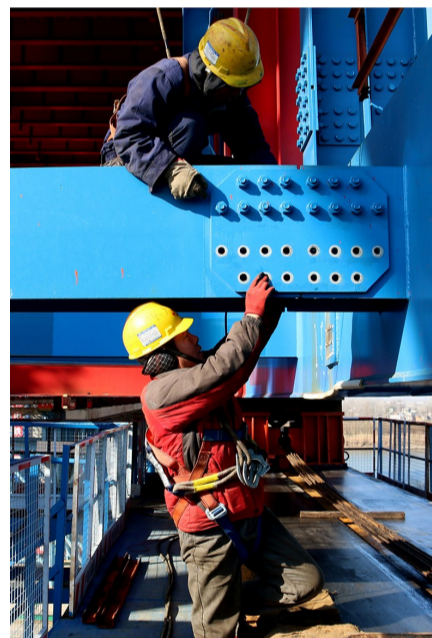
导梁拆除作业
