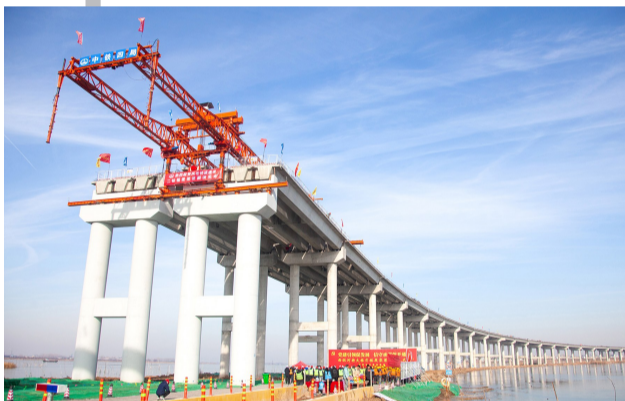
最后一根箱梁架设完成
