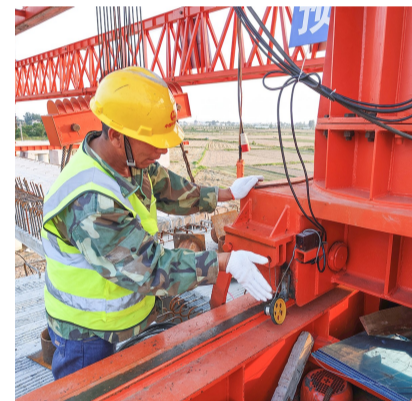
架梁工人检查架桥机
