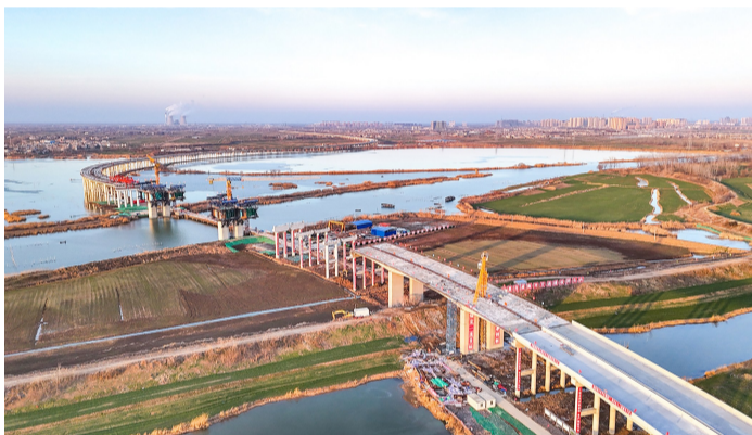
施工中的西淝河特大桥
