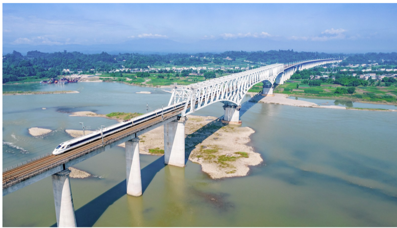
成贵铁路五通岷江特大桥 蔡朝阳 摄
