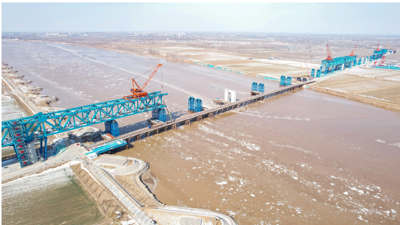
钢结构建筑公司雄商高铁黄河特大桥项目各项施工准备已就绪,具备复工大干条件
