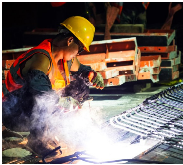
一公司雄商一分部钢筋焊接施工
