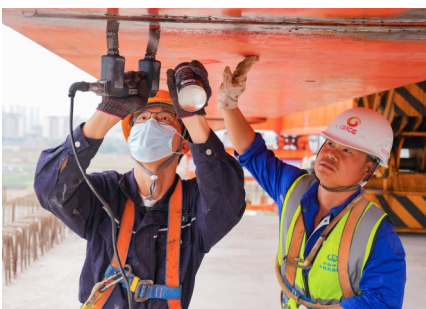
八分公司崇凭铁路项目部架设那桐特大桥第63孔箱梁,作业人员在重载情况下进行架桥机臂无损探伤检测
