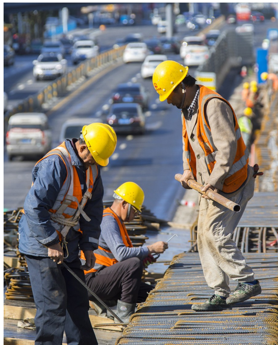
四公司合肥淮南路项目工人正在进行钢筋绑扎
