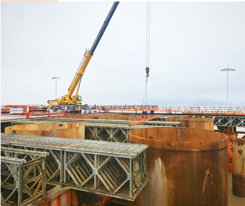
二公司甬舟铁路西堠门公铁两用大桥项目部建设者正在进行起吊作业
