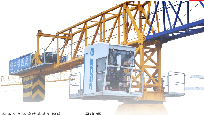
李丹正在操作塔吊吊装钢筋
