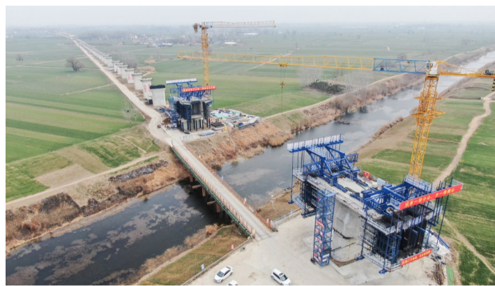
悬臂智慧造桥机在阜淮铁路站前1标跨北淝河特大桥应用
