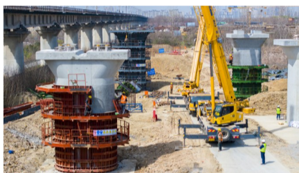
墩身模板吊装作业
