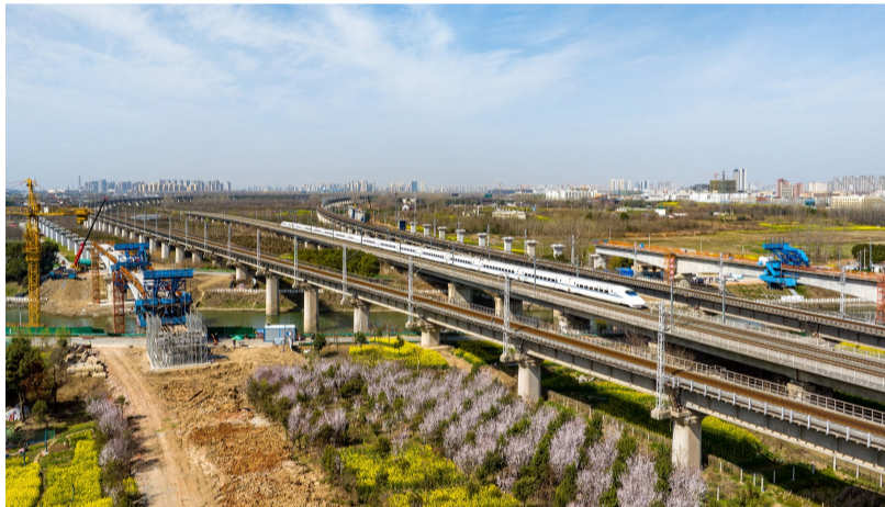
沪宁合高铁跨店埠河特大连续梁施工
