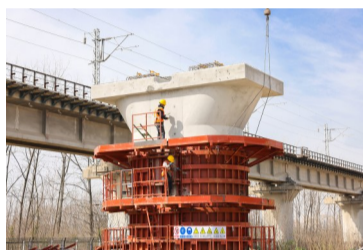
墩身模板拆除作业
