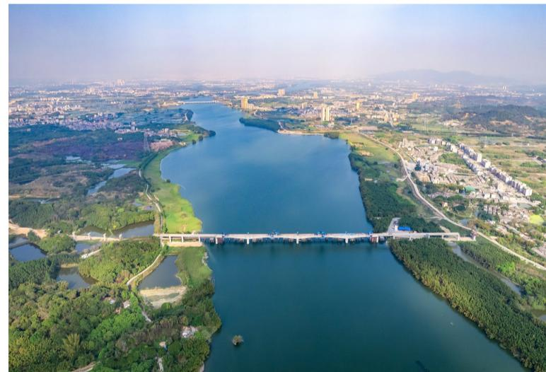
3月29日,中铁四局五公司承建的揭(阳)惠(来)铁路榕江南河特大桥主跨连续梁合龙。该项目正线全长88.66公里,其中,榕江南河特大桥全长1576.84米,是揭惠铁路全线跨越水域最长、涉水最深的桥梁。
