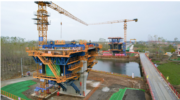
悬臂智慧造桥机应用在沪渝蓉高铁跨民乐渠连续梁施工
