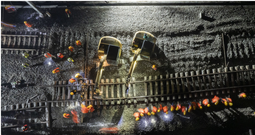
作业人员配合机械进行线路拨接
