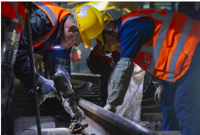
安装钢轨扣件
