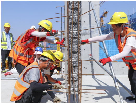
李宏 摄 叠合板安装
