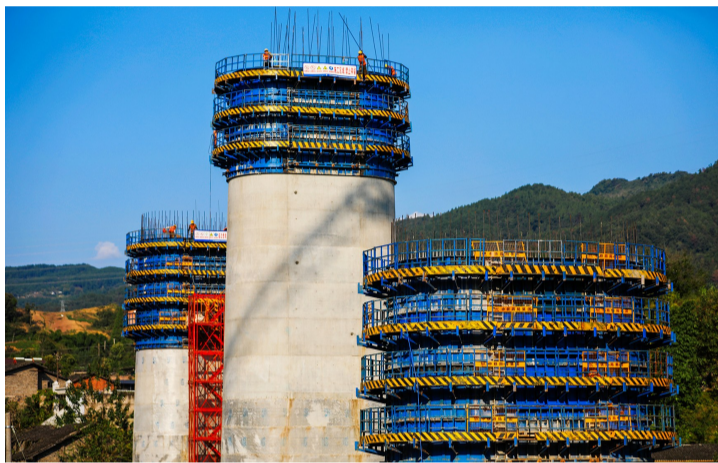
桥梁墩身施工
