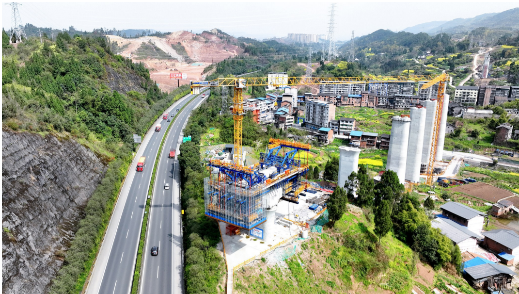
西渝高铁侯郎特大桥施工现场
