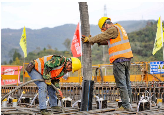
连续梁混凝土浇筑
