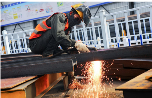
隧道拱架焊接
