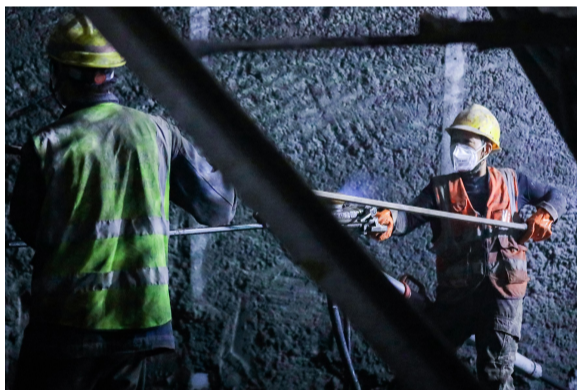
工人正在进行超前锚杆施工
