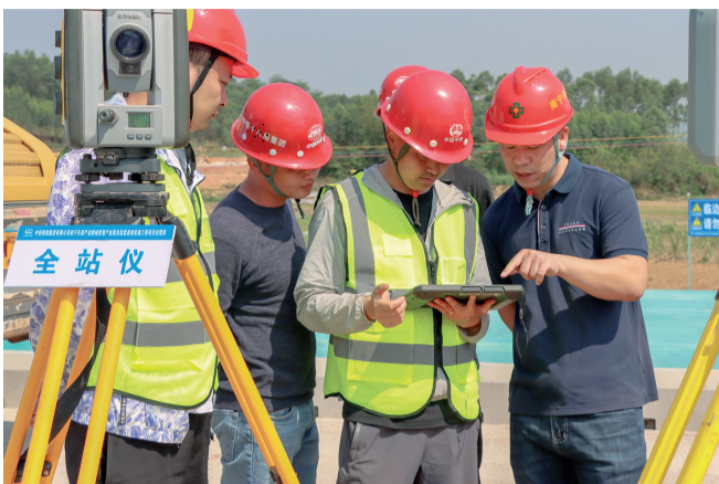
技术人员学习交流3D无桩化智能摊铺施工
