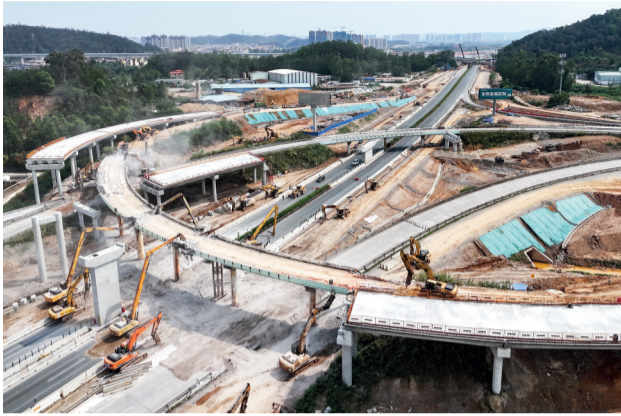
小金口互通立交D匝道桥旧桥拆除
