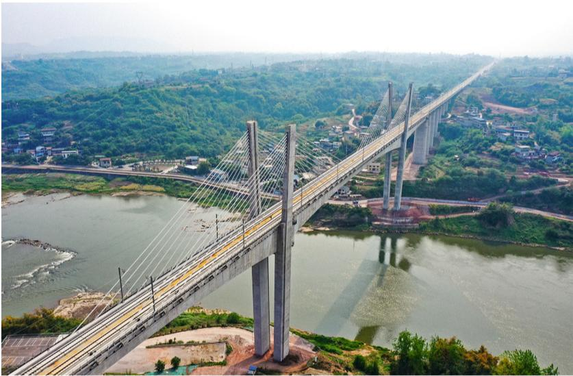
4月15日,中铁四局渝(重庆)昆(昆明)高速铁路川渝段4标项目部(二公司)承建的泸州沱江特大桥开始静态验收。渝昆高铁全长698.96公里,设计时速350公里。川渝段4标全长31公里,施工内容包括40座桥梁、39段路基、23座涵洞和550公里轨道工程。其中,泸州沱江特大桥全长2.6公里,是国内高速铁路建设中首次采用双柱式V型桥塔、空间扇形索面斜拉索的斜拉桥。 丁顺 王昊 摄
