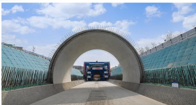
雄忻高铁大开挖衬砌施工
