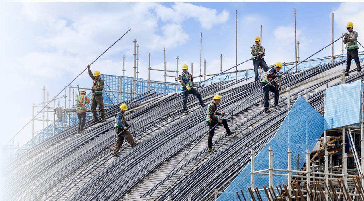
雄忻高铁先开段萍河西大堤拱型墩钢筋绑扎
