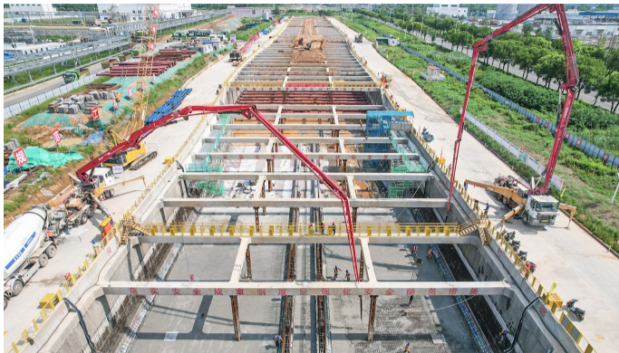
仪禄高速唯一明挖隧道——青山隧道底板混凝土浇筑
