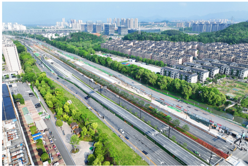
4月30日,中铁四局三公司承建的杭州市文一西路西延工程一期地面主干道(智温路至城东路段)通车。该工程全长1.855公里,施工内容包括市政隧道、地面道路和隧道通风等。
