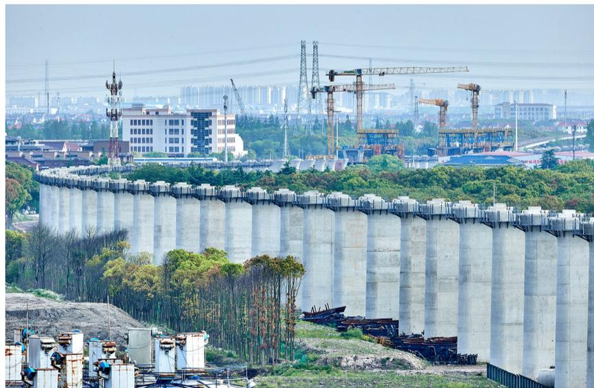
“五一”期间,中铁四局二公司承建的沪(上海)苏(州)(南)通铁路二期站前Ⅶ标正在加紧施工。沪苏通铁路二期工程北起沪苏通铁路太仓站,南接浦东铁路四团站,全长111.8公里。中铁四局承建标段线路全长36.768公里,施工内容包含路基、桥梁、箱梁制架、上海动车所等工程,目前已全面进入桥梁上部结构和路基主体施工阶段。项目建成通车后,对推进长江经济带海铁联运发展、贯彻落实长三角一体化国家战略具有重要意义。
