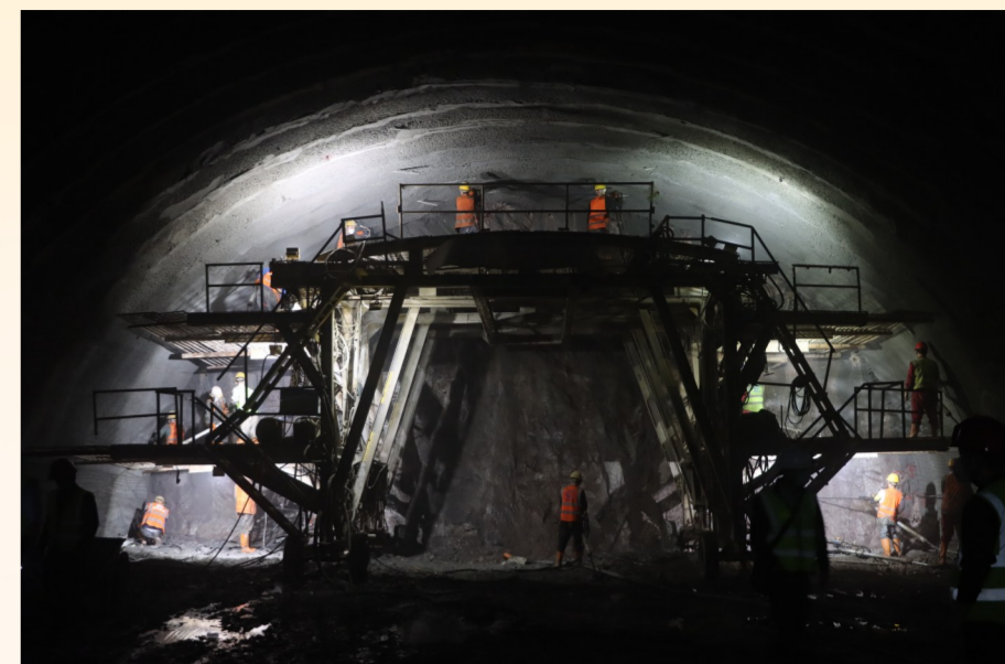
戴天骥 摄 七分公司胶州湾第二海底隧道掌子面施工
