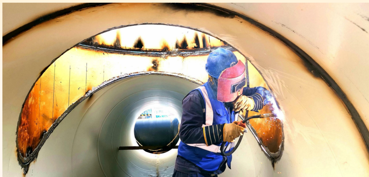
市政公司宿松县第三自来水厂及配套管网项目工人进行焊接作业
