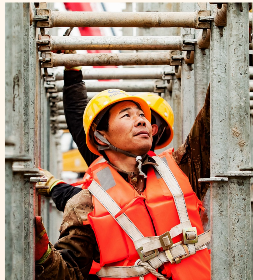
三公司雄安白沟引河留通桥项目施工现场一片繁忙
