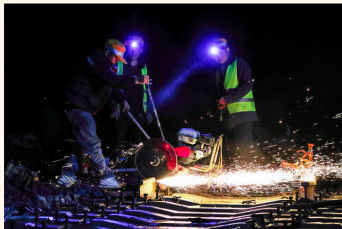
六公司大唐延安电厂铁路专用线引入替河村站改造项目建设施工忙 徐鹏飞 摄
