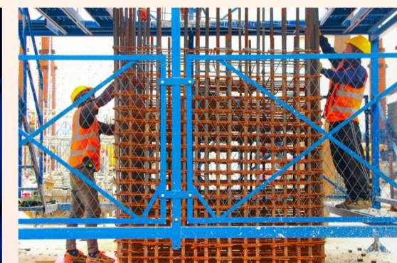
建筑公司宁(南京)马(鞍山)城际铁路滨江车辆段建设者一丝不苟,拧紧每一个环扣以确保盖板浇筑节点顺利达成 吴茹 摄
