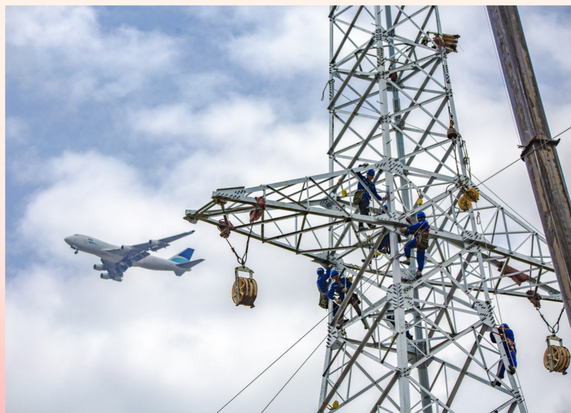
电气化公司(天津)津(坊)高铁济南联络线JBTJ-1标项目工人正在紧张有序进行施工
