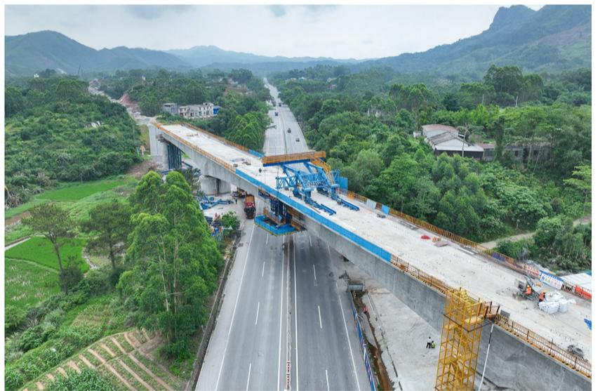
5月8日,中铁四局五公司承建的南(宁)深(圳)高速铁路玉林至岑溪段3标跨G324国道特大桥连续梁合龙。3标管段全长20.9公里,施工内容包括21座桥梁、8座隧道、13段路基等。其中,该特大桥长979.93米,采用(60+100+60)米连续梁结构。
