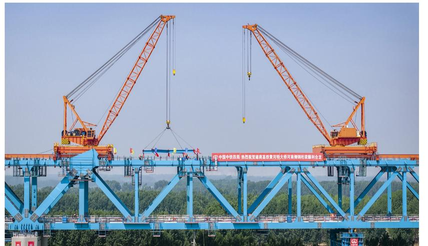
5月18日,中铁四局承建的雄(安)商(丘)高速铁路黄河特大桥主桥河南侧顺利合龙,截至目前,全桥钢桁梁架设进度超87%。该桥总长1600米,在河南省濮阳市台前县、山东省济宁市梁山县间跨越黄河,是雄商高铁项目重要控制性工程之一。
