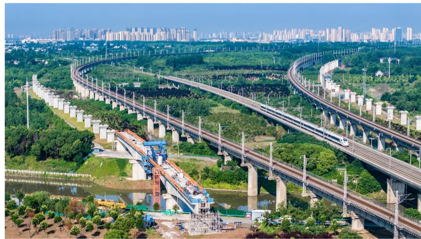
5月28日,中铁四局四公司承建的沪(上海)宁(南京)合(肥)高速铁路引入合肥枢纽工程跨店埠河特大桥左线首个连续梁合龙。该连续梁分20个标准节段,采用2对菱形挂篮分段悬臂浇筑施工,混凝土浇筑总量达1866.2立方米。
