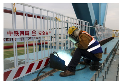
工人正在进行焊接作业
