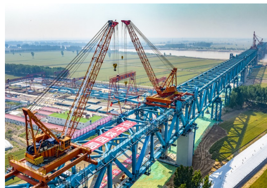
架梁吊机正在进行吊装作业
