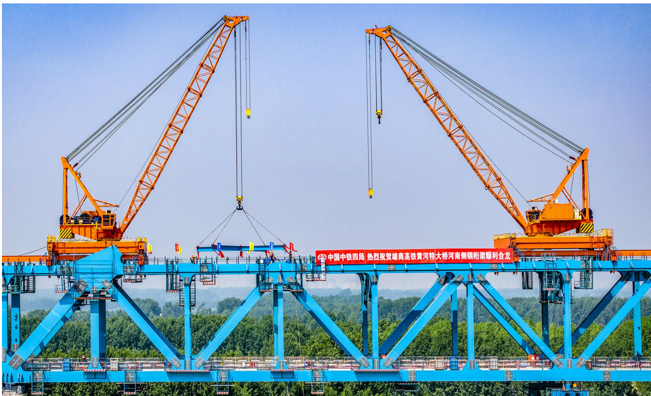
雄商高铁黄河特大桥主桥河南侧钢桁梁顺利合龙
