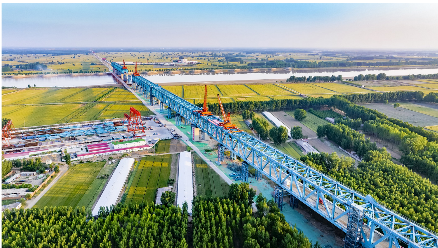
建设中的雄商高铁黄河特大桥
