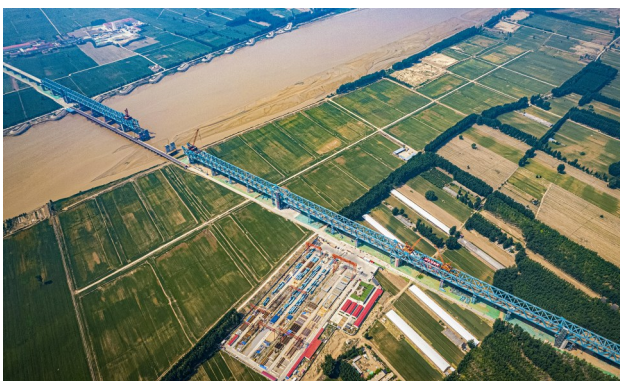
雄商高铁黄河特大桥河南侧建设掠影
