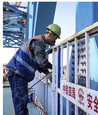
工人在高栓区域防腐涂装作业
