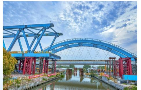
动车双线特大桥系杆拱施工现场
