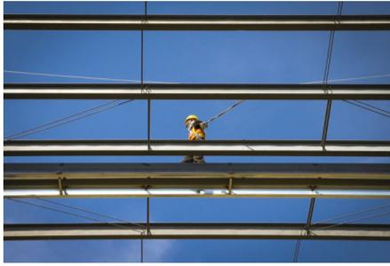
工人正在检查上海东动车所钢结构网架
