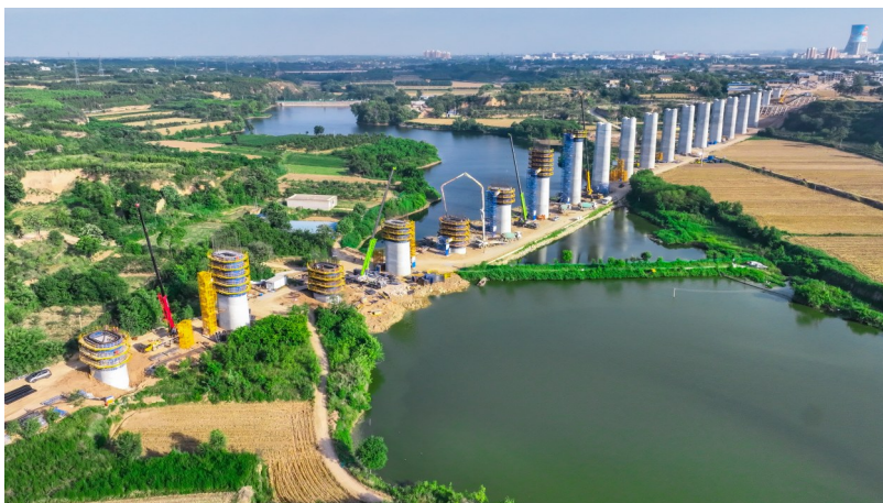
西延高铁富平特大桥墩身施工
