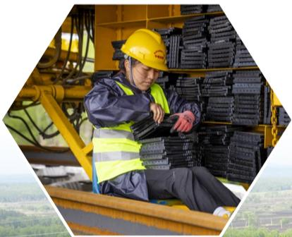
工人整理钢轨橡胶减振垫片
